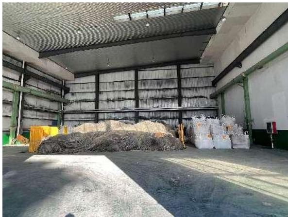
自产危废库暂存现状
