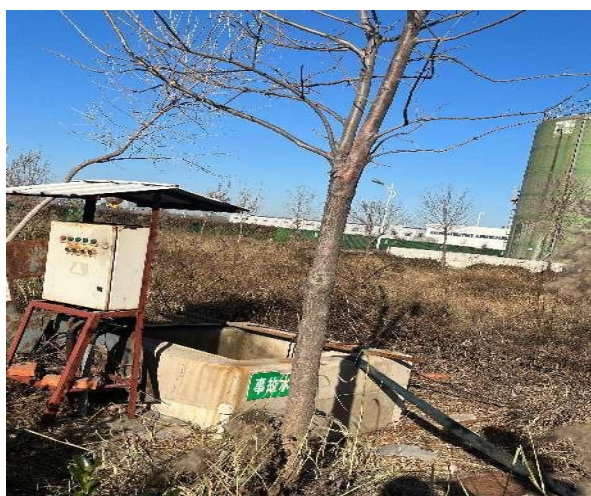
事故水池（埋地构筑物）
